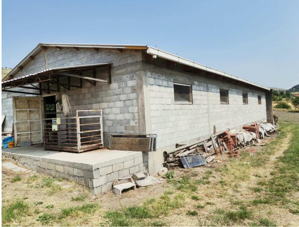
Слика: Објект за одгледување на свињи
